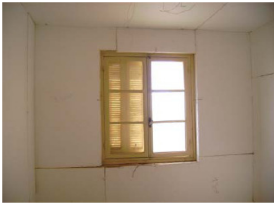
Fig.(3.26): Surface intérieure du mur Sud.
